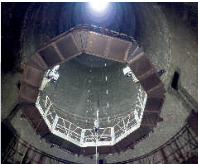
Remont komina H=120 Elektrociepłowni Skawina, konstrukcja podestu na bazie GEDA AB 650
