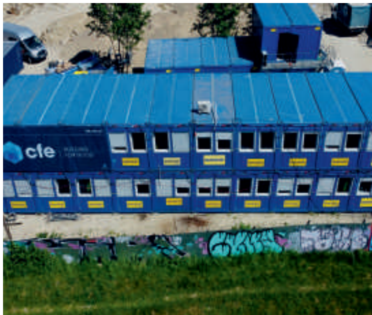
Budowa Designer Outlet Kraków
