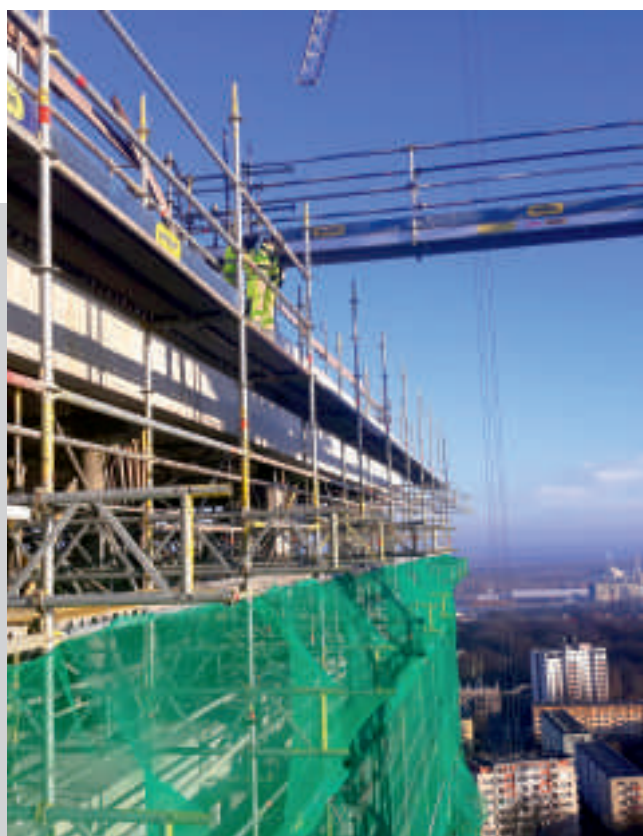
Hanza Tower Szczecin- kładka -pomost Alusteg (lekki aluminiowy element konstrukcyjny) firmy Layher o długości 10 m jako element przewieszenia pomiędzy budynkiem a żurawiem wieżowym.
